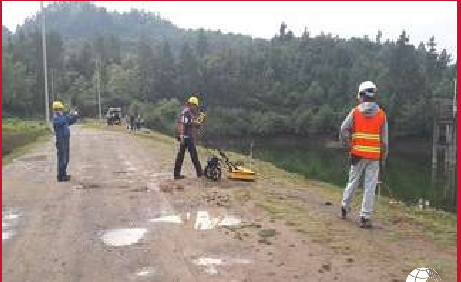
DIAGNÓSTICO, ESTUDIOS Y PROYECTO DE INSTRUMENTACIÓN DE LAS 5 PRESAS, SISTEMA HIDROELÉCTRICO NECAXA, PUEBLA
