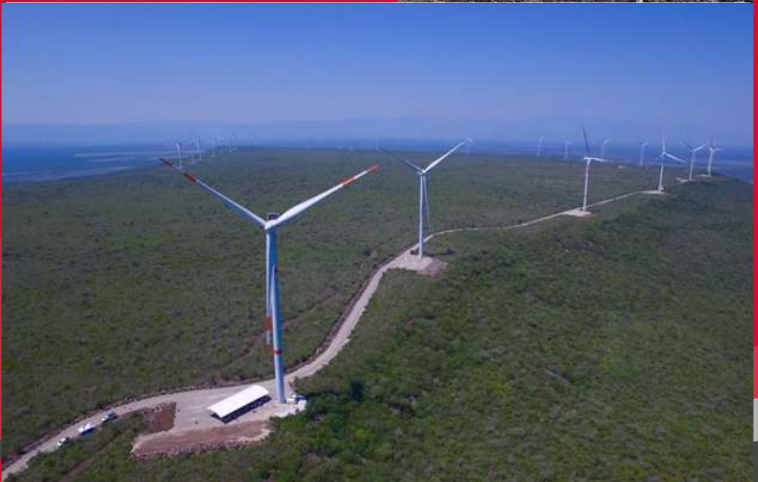
2.- PARQUE EÓLICO REYNOSA, TAMAULIPAS.
